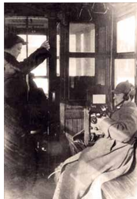
Исследование радиопомех, создаваемых трамваем (1935 г.)
